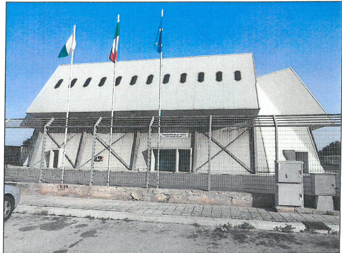
Riqualificazione architettonica e funzionale dell' AGORA' polifunzionale in zona periferica "Pala Pansini".
